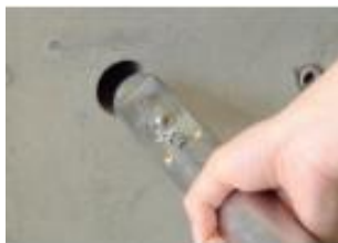
ファイバースコープによる孔内挿入状況
